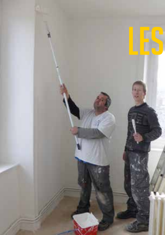
Les employés communaux aux travaux de rénovation
